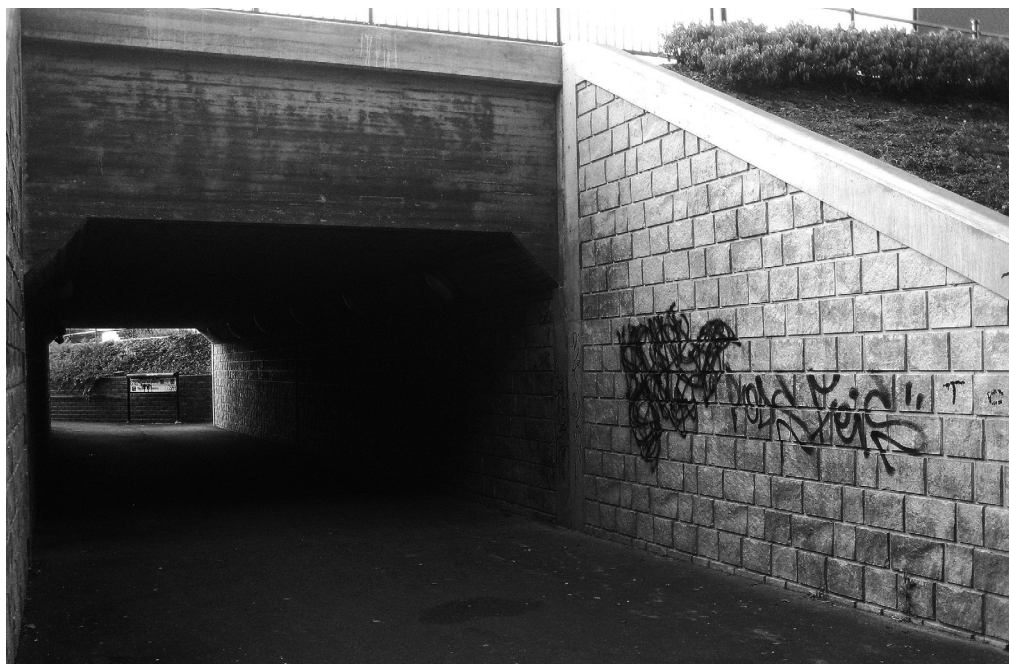
Bild 4: Gångtunneln vid Kimstad pendeltågsstation. Foto: Ann-Charlotte Gilboa Runnvik
